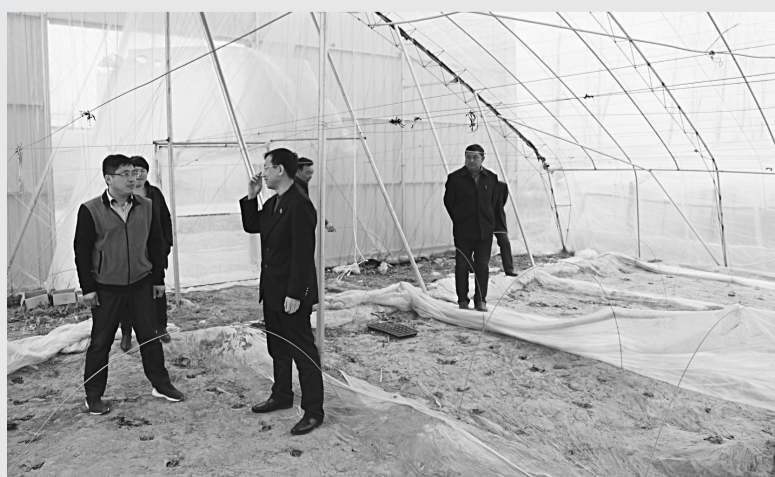
扶贫工作人员在蔬菜大棚建设现场查看施工进度。
