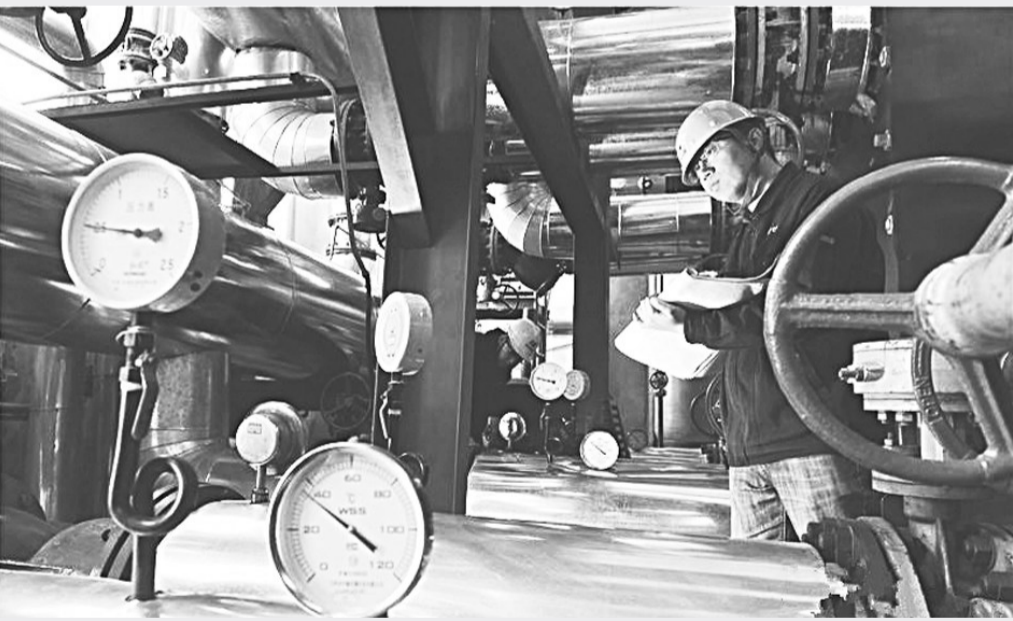
11月14日,石家庄华电供热集团有限公司裕华管理处3302换热站,工作人员正在对管网压力、温度等监控设备运行情况进行记录,并进行最后的微调。据介绍,该集团供热面积覆盖石家庄市近2000个小区,占石家庄市总供热面积的50%以上。截至当日中午,其所辖热源网温度均已达到供暖标准,自控换热站已进入正常供暖的运行状态。赵海江 摄
