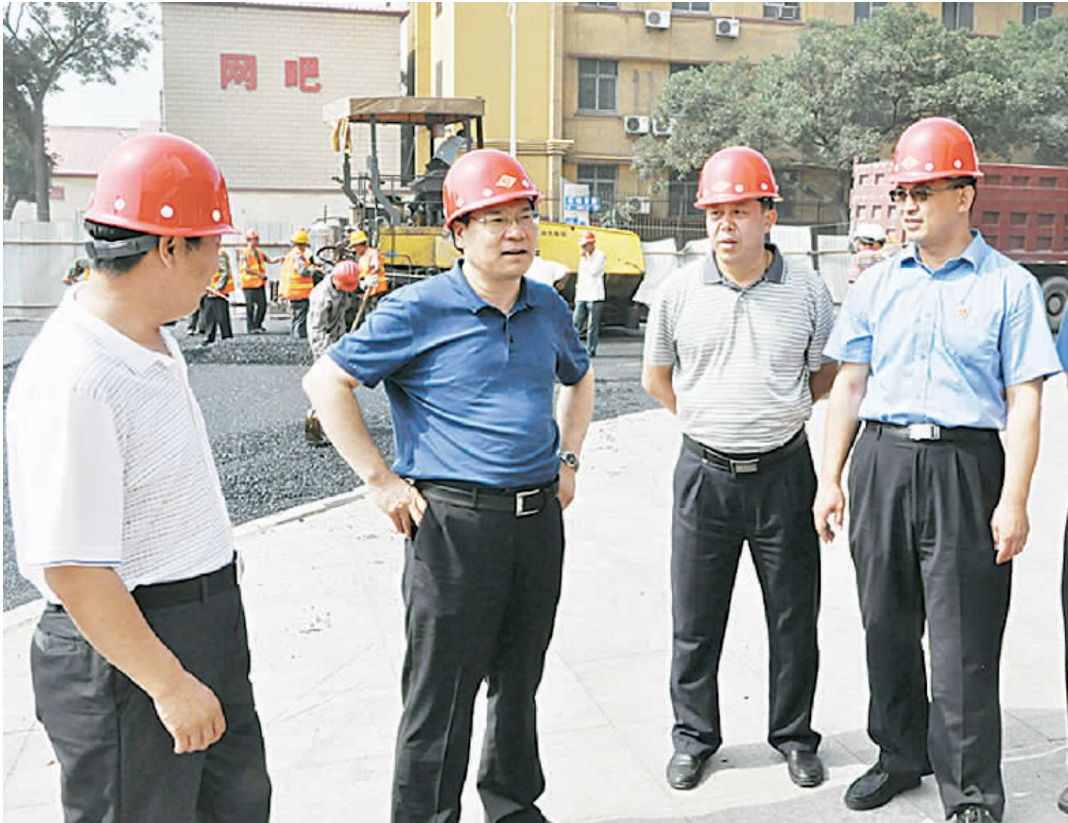
宣化区检察院检察长葛阿刚一行到宣化车站西街道路铺装现场指导犯罪预防工作。
