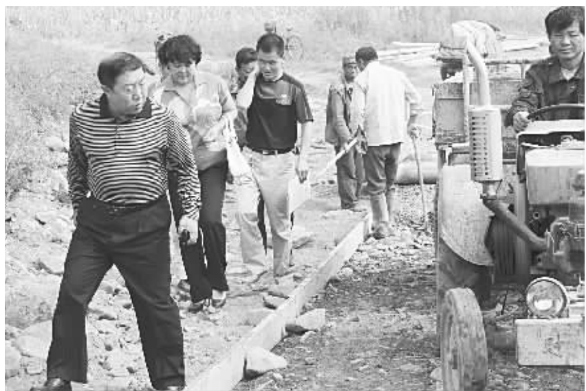
资讯图片:丰宁检察院帮扶汤河乡西湾子村修建水泥路,检察长蒲英华(左一)多次到施工现场督导工程质量和工程进度。
