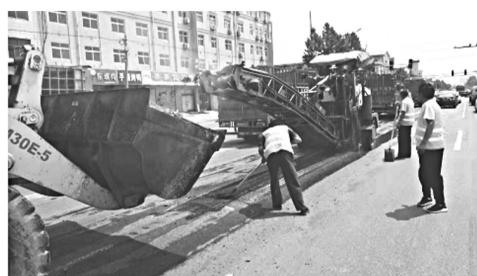
近日,正定县公路管理站集中开展环境整治,对辖区公路两侧行道树、绿化带进行统一修剪,集中处理绿化带内枯枝残叶、杂草垃圾,并及时修补路面病害,提升道路行车舒适度。图为该站人员正在顶着酷暑修补病害路面。高士光 贾小敏 摄
