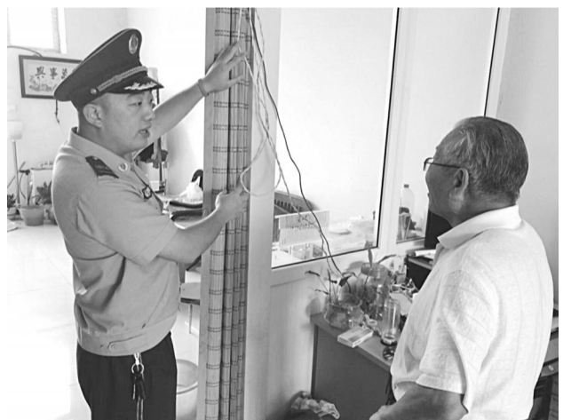
为做好电气火灾防范工作,三河市政府对全市电代煤用户、气代煤用户和沿街商铺进行电气安全检测。三河市消防大队消防人员联合第三方检测机构工作人员采取“听、问、看、测、查”等方法开展“会诊式”检测,逐户家庭、逐栋建筑检查,清查隐患,确保不留死角。潘玉婧 摄
