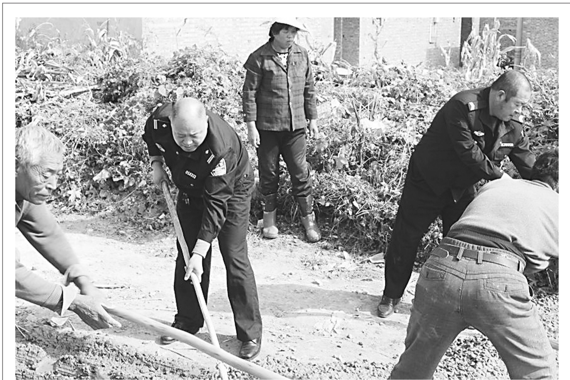
今年7月19日,武安市遭遇百年不遇的大洪水,辖区南山底村多处道路被洪水冲毁、冲塌,村民的正常生活受到了影响。10月11日,武安市交警大队城区中队中队长李广军带领民警来到南山底村,组织村民共同修复损坏道路,保证村民正常出行。图为施工现场。李换巧 摄
