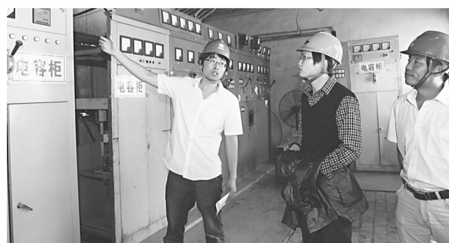
为确保迎峰度夏电网安全稳定运行和客户安全用电,杜绝高危客户各类电气事故的发生,国网怀安县供电公司组织对高危客户进行了安全大检查。图为该公司人员深入张家口华贵矿业有限公司进行检查,并认真听取客户对供电服务的意见和建议。 张海英 崔莹 摄影报道
