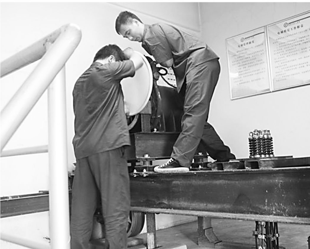
为进一步提高使用单位面对突发事件的应变能力及迅速处置能力,在实践中检验电梯使用方及维保方电梯事故应急救援水平,近日,邯郸市丛台区市场监督管理局在邯郸市第一医院组织开展了电梯安全事故应急救援演练。图为演练现场。记者 刁军杰 摄
