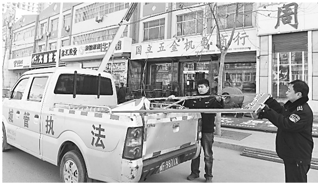
定州市从1月22日起开展全市街道沿线违规广告牌全面清理活动,消除违规广告牌的安全隐患及视觉污染,提升城市形象。活动开展以来,清理违规广告牌50余块,清理、覆盖小广告10440处,拆除市区违规悬挂门头牌匾1120处,查封违规设置落地牌匾1165块。同时,制作完成235块公益广告。
