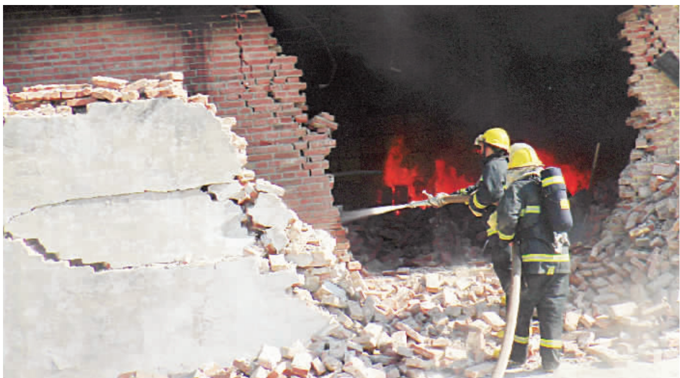
5 月 4 日 12 时 12 分，香河县淑阳镇前套村一家具仓库发生火灾。廊坊消防支队香河中队接到报警后，立即出动两部水罐消防车及 12 名官兵赶赴现场救援。起火仓库已经坍塌。消防官兵分成两组，从起火库房南北两侧进行扑救，防止火势蔓延，同时联系其他中队进行增援。15 分钟后，增援消防车辆到达，加快灭火进程。当日 19 时，大火被成功扑灭。目前，火灾原因正在调查中。图为消防队员在现场奋力灭火。 孙大力 刘蕊 摄
