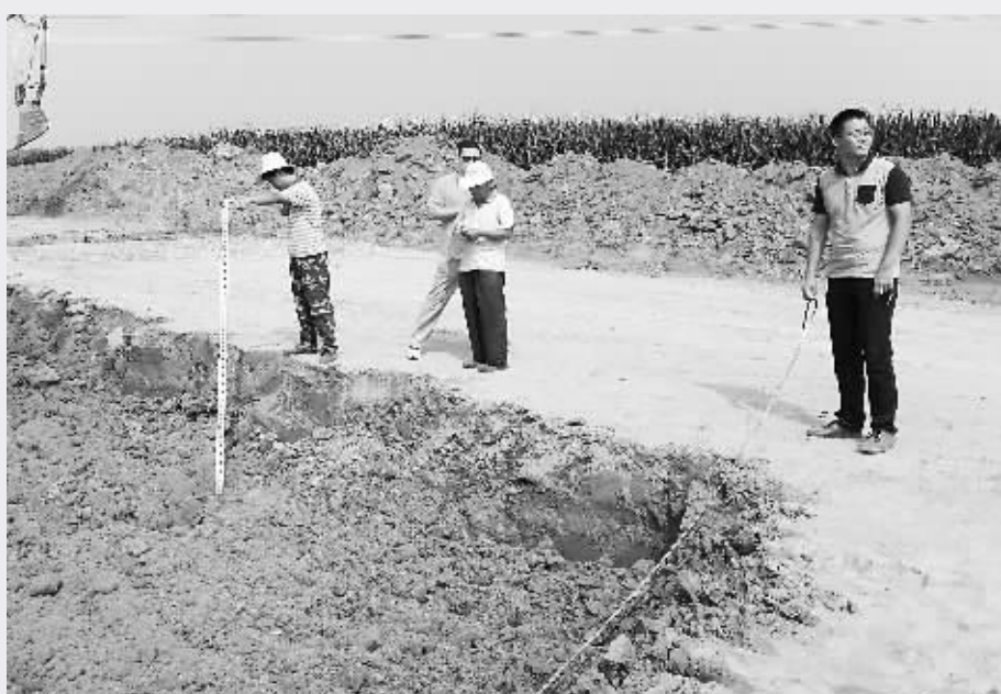
今年以来,临漳县审计局在政府投资审计中,加大了对建设项目隐蔽工程跟踪审计力度,防止施工单位对设计变更、工程签证确定工程量的随意性。图为审计人员在软弱基层处理进行现场查勘测量。徐雷 赵忠彬 摄
