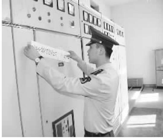
5月5日,石家庄市公安消防支队鹿泉大队民警深入辖区单位开展消防安全检查。检查过程中,执法人员发现辖区一企业存在严重占用疏散通道、安全出口上锁等消防安全隐患。执法人员依法对该单位实施了临时查封,并告知单位负责人立即进行整改。图为消防执法人员在查封企业设备。本报记者 刘波 摄
