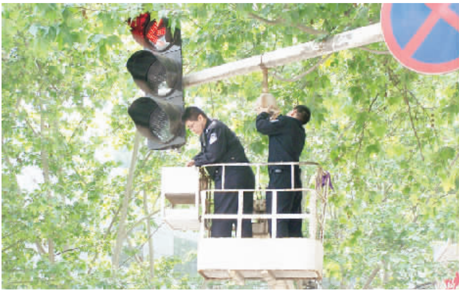
民警检修视频监控系统,保障“天网”一览无余。
