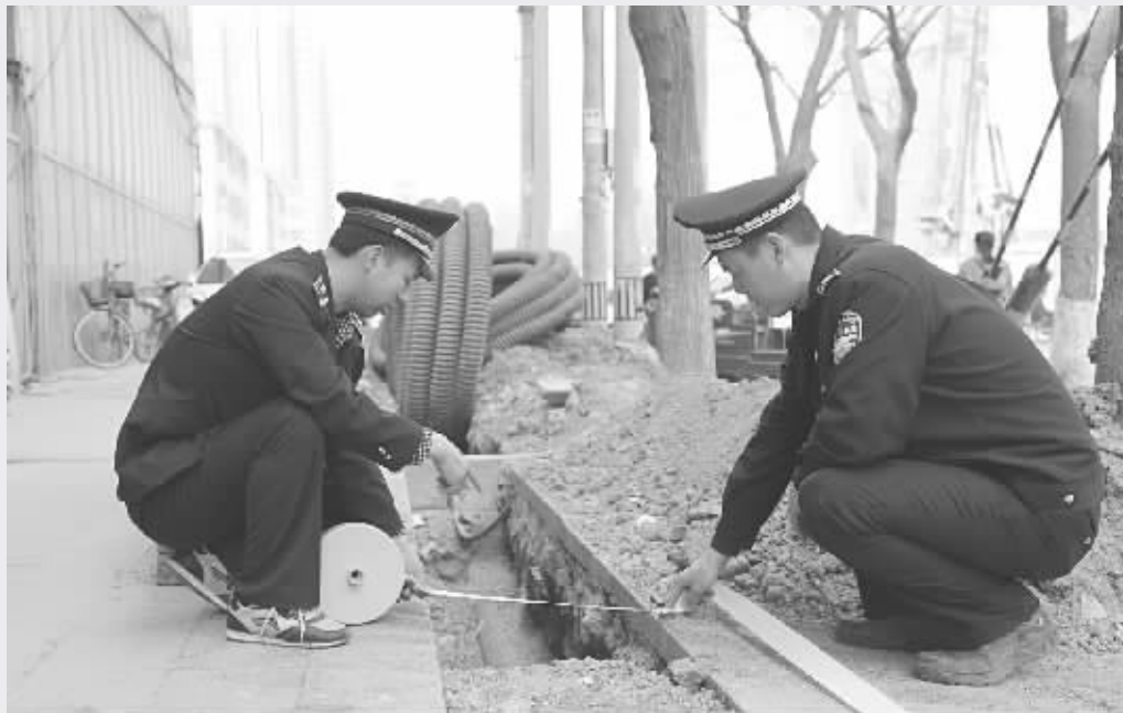
一些施工单位未经城市管理部门审批擅自挖掘、占用城市市政道路，建筑垃圾、建筑材料无序堆放、占压市政设施，建筑渣土未按规定装载运输、任意倾倒，沿途遗撒，给市民出行带来极大不便。近日，石家庄市城管执法支队对这些行为进行了专项治理。图为执法人员正在施工现场调查，要求施工单位做好安全围挡及文明施工标示牌后方可继续施工。
