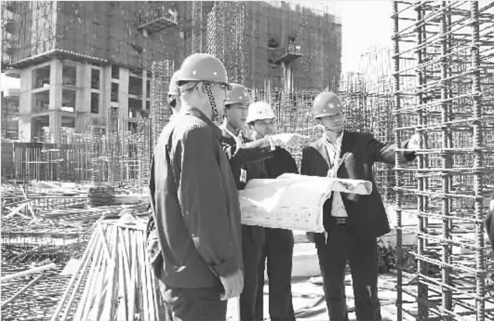
随着建筑工程施工进入旺季，沧州市住建局近日及时组织工程质量执法监督人员深入施工现场，对保障性住房、医院、学校等在建工程质量进行重点监控，为建筑工程质量安全提供了保障。图为该局工作人员正在施工现场走访。
