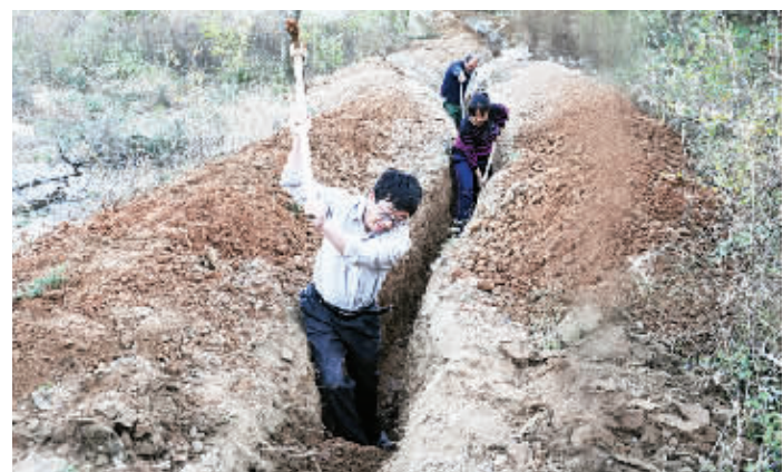
张家口市检察院驻涿鹿大南山台峪村工作组,在驻村帮扶过程中,深入农户认真走访,耐心听取民意,积极开展工作。他们筹集资金100余万元盖起了村“两委”办公用房,建起了垃圾池,硬化了村内道路。为改善农村饮用水质量,他们还筹集资金10余万元,购买1万余米引水管道。图为驻村工作组组长张慧军带领村民开挖铺设引水管道的填埋沟。 卢江 摄
