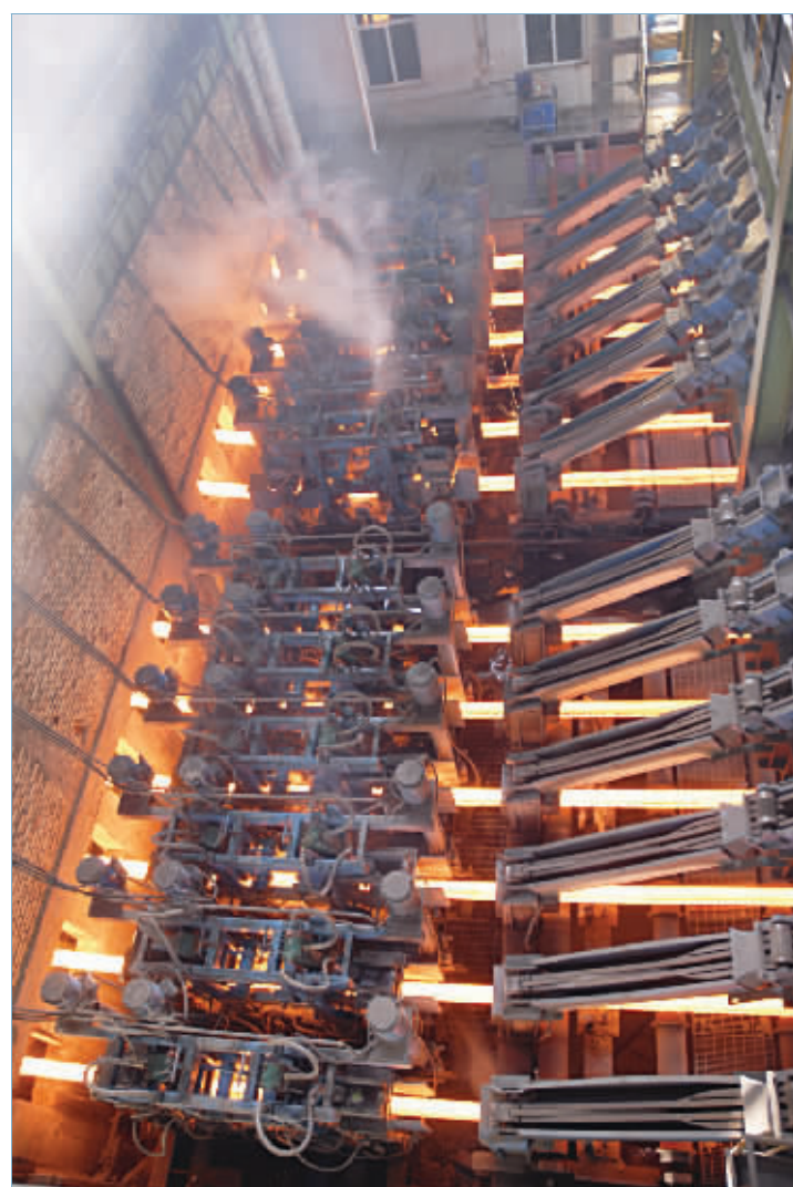
河北钢铁建设集团承建的12机12流连铸机工程。
