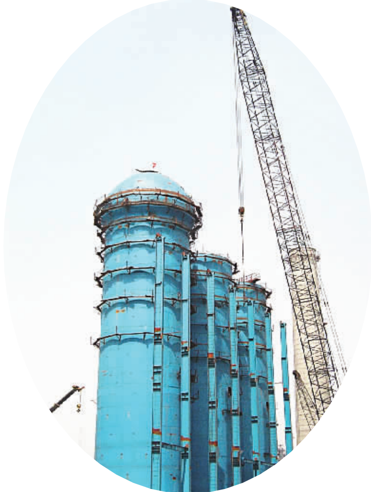
河北钢铁建设集团承建的热风炉工程。
