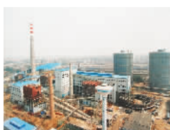
河北钢铁建设集团承建的360M 3 烧结机工程。
