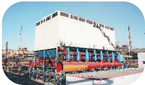
河北钢铁建设集团大型环保项目——除尘设备安装场面。
