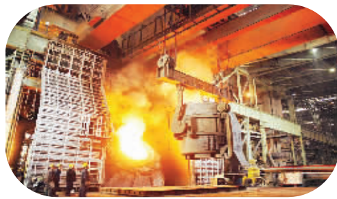
河北钢铁建设集团承建的120吨转炉工程。
