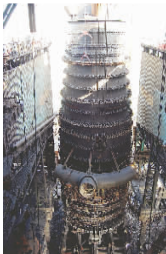
河北钢铁建设集团承建的3200M 3 高炉整体推移项目。
