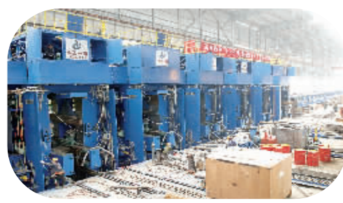
河北钢铁建设集团建设轧钢生产线。
