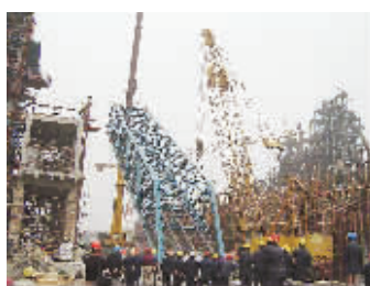
河北钢铁建设集团承建的大型高炉施工场面。
