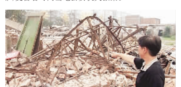
两家企业的建筑已成为一片废墟。李建华 摄
