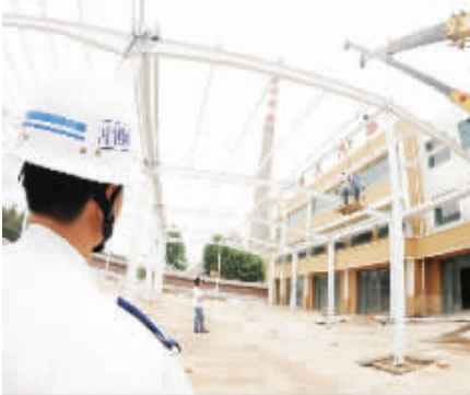
图为城管组织拆卸工人配合机械拆除非法构筑物现场。 郝德明 摄
