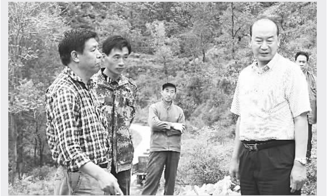
图为张振庄在马渠水村蓄水池的工程现场。 记者 刘波 摄
